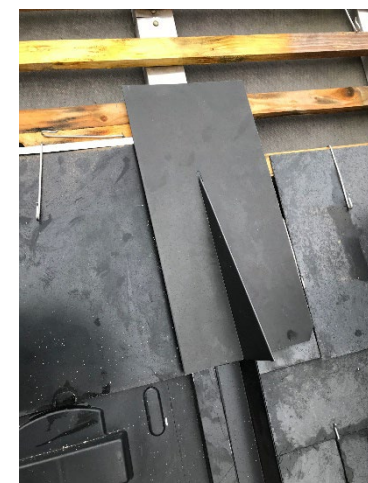
Fig 2. Mise en position
