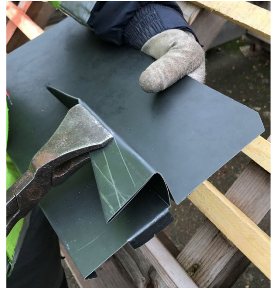
Plier de l'aileron (à mi hauteur, de façon Faire un pli à 180°)
