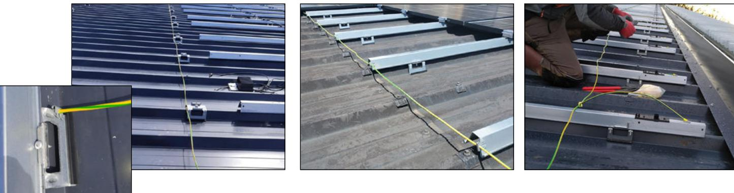
Une liaison équipotentielle de protection 6mm<sup>2</sup> vert/jaune Cu ou équivalente sur toutes les colonnes de rails est nécessaire. Cette liaison sera reliée à la terre de l'installation.
