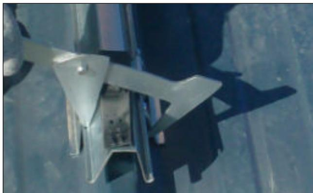
Selon le plan fourni par dome solar, commencer toujours en bas de générateur par un rail 3 ou 4 modules.
